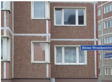
Unsanierte Plattenbauten – Großes Berlin
