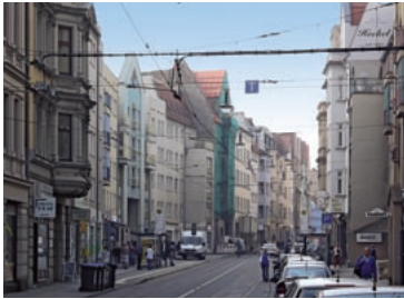
Wohn- und Geschäftshäuser Steinweg
